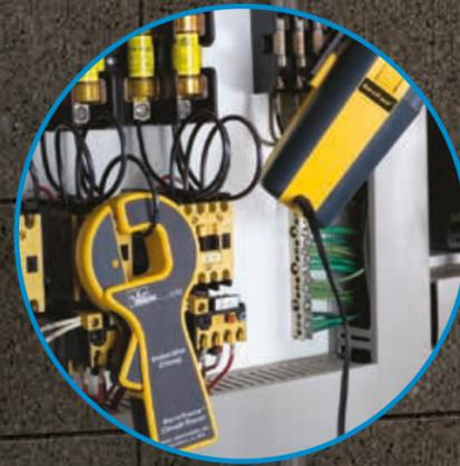
La pinza inductiva permite inducir una señal de rastreo en el cable sin afectar a las señales de bajo voltaje del circuito.
