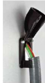
2. Insert conduit with cables
